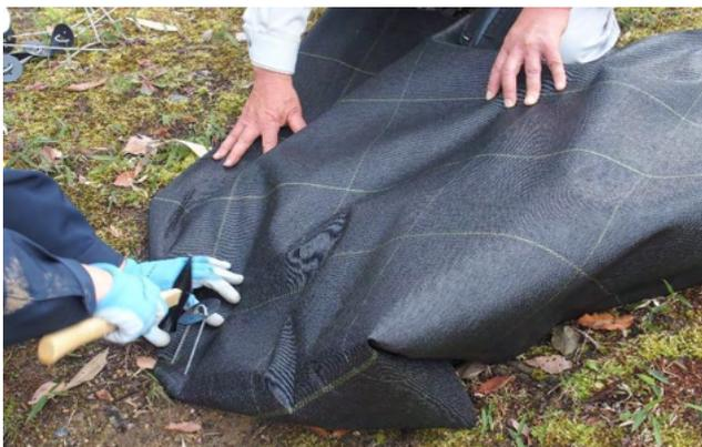
◆シートの周りに黒丸君を打ち込み、地面に固定し完了。
