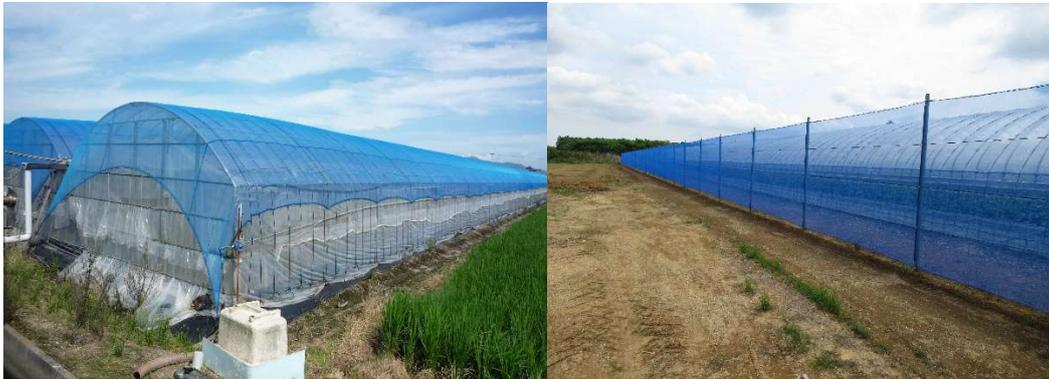
左：ムカデ加工（約2 m間隔でロープが縫い込まれておりハウスの浮き上がりを抑えます。）
